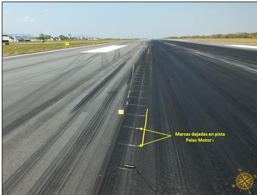
Fotografía No. 3: Marcas sobre la superficie asfáltica (puntas palas de la hélice)
